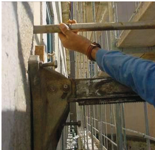
Figura 5: Pregagem entre paredes para reforço da sua interligação
