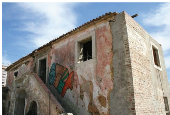
Figura 2: Reconstrução de troço de parede com alvenaria à base de cal aérea
