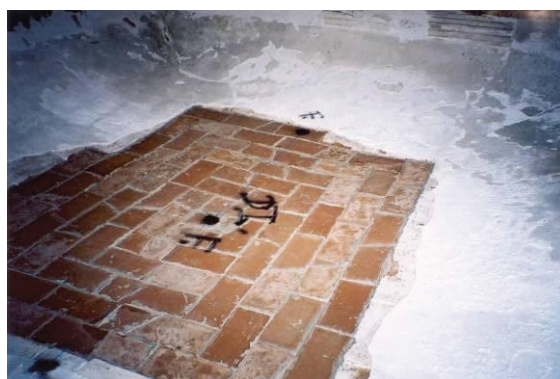
Figura 3: Reconstrução de troço de abóbada com juntas argamassadas à base de gesso ou cimento de presa rápida
