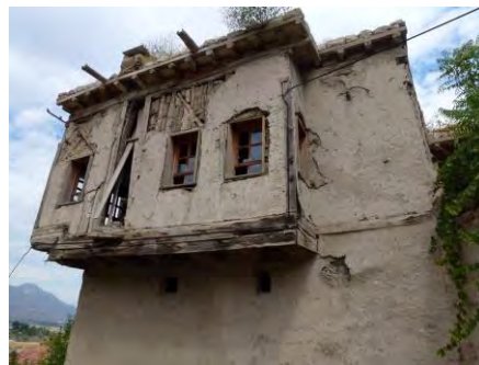
Figure 5: Hımış house in Divriği.
